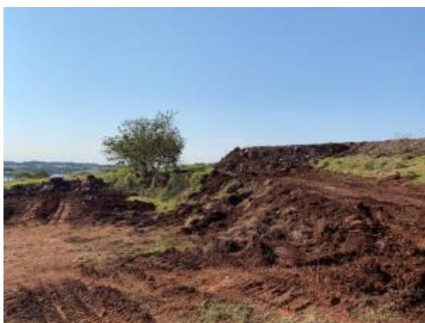
Estrutura de concreto e depósito de cascalho sendo removidos.
