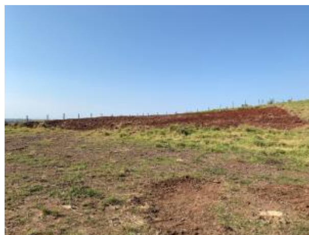
Baia de contenção desmobilizada.
