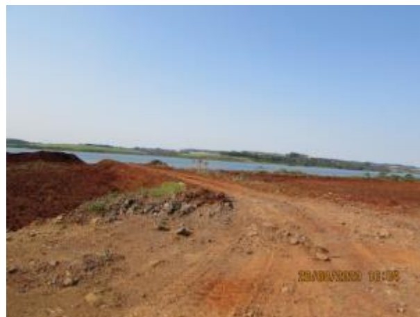
Início da remoção dos taludes das lagoas
