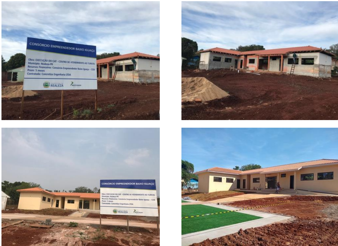
Figura 4-22 Evidências fotográficas reforma e construção do CAT
