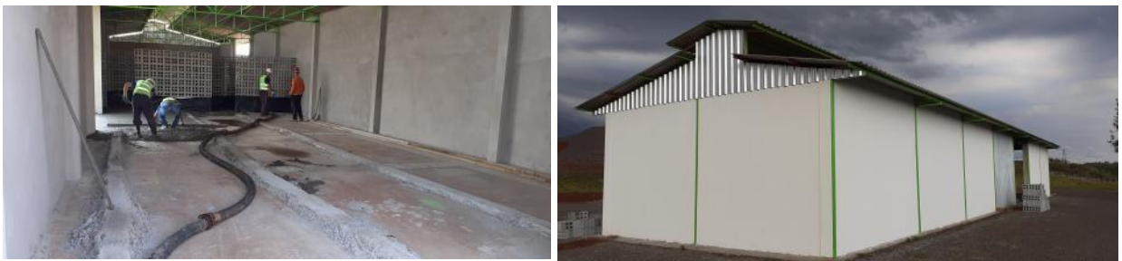
Andamento a construção Depósito de Óleo e Resíduos (DOR).
