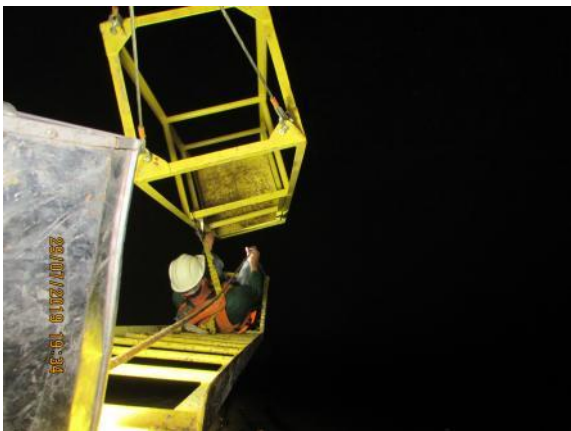
Descida da equipe no interior do tubo de sucção da UG-01 para as atividades de resgate de ictiofauna.
