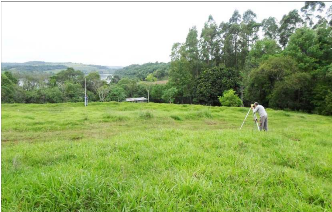
Figura 34 - Levantamento e aplicação das linhas de controle horizontal.
