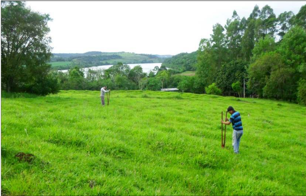
Figura 37 - Abertura de sondagens por cavadeiras manuais.
