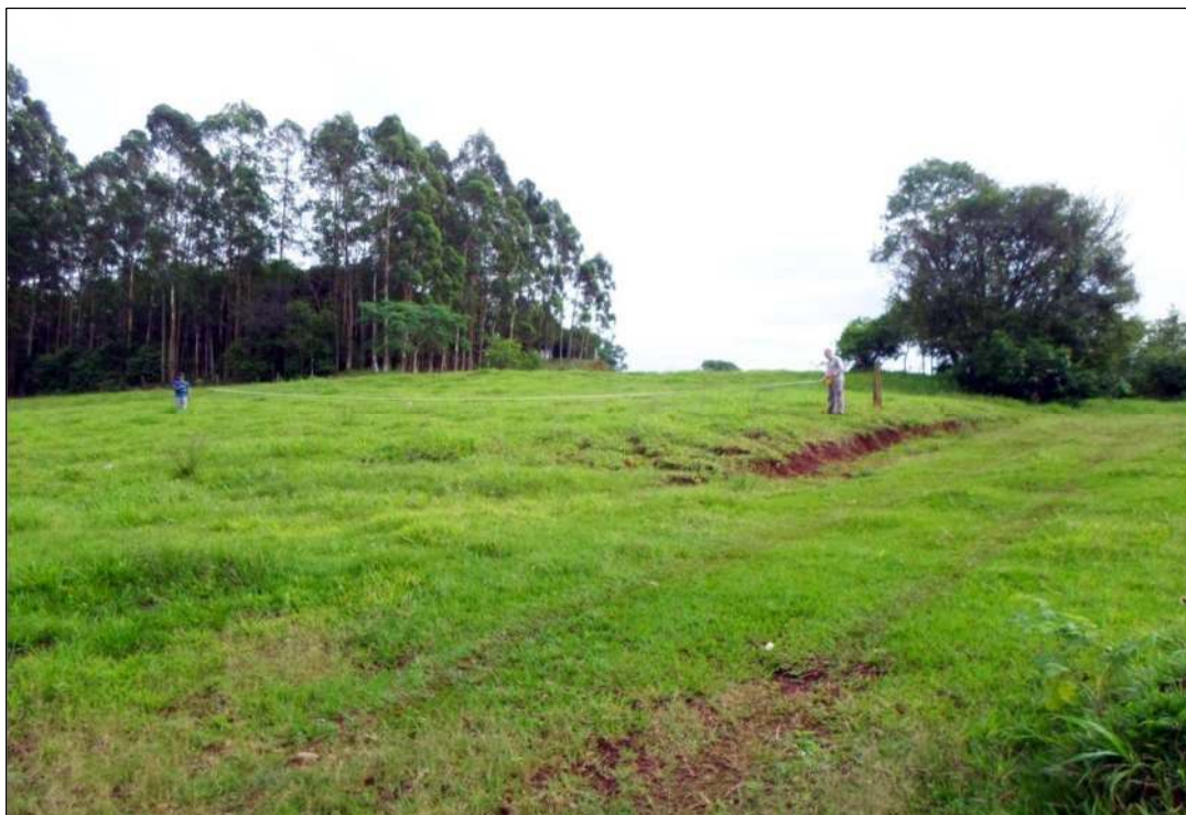
Figura 35 - Demarcação dos pontos para abertura de sondagens.
