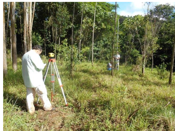
Alinhamento da área a ser trabalhada.
