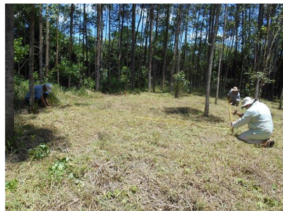
Piqueteamento do local para a abertura da quadra.
