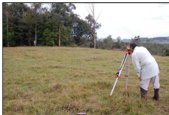
Alinhamento da área a ser trabalhada.
