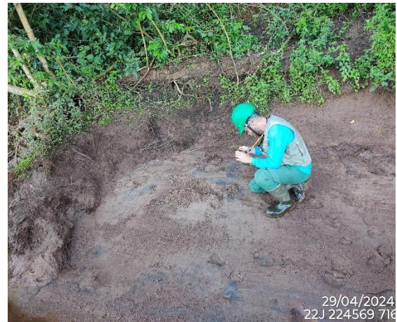
Foto 16. Vistoria em margens.
