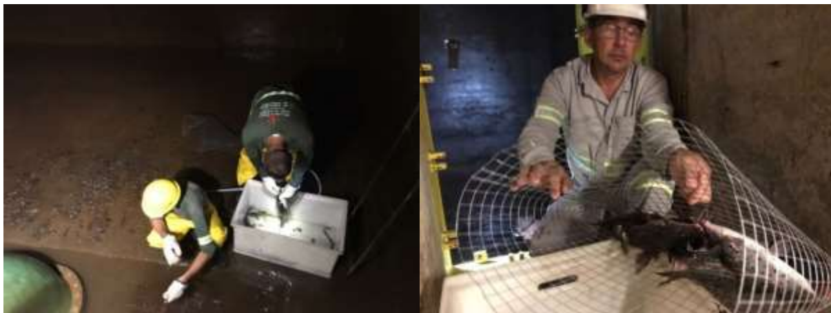
Figura 6 - Resgate poço de esgotamento
