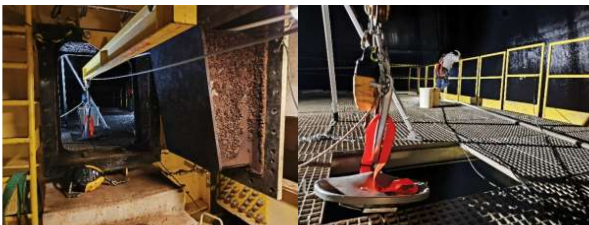
Figura 3 - Acesso e inspeção visual do tubo de sucção da UG-01.
