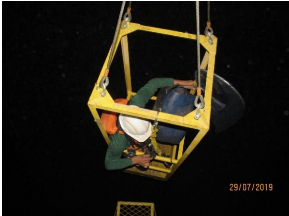
Figura 12. Descida da equipe no interior do tubo de sucção da UG-01 para as atividades de resgate de ictiofauna, julho de 2019.
